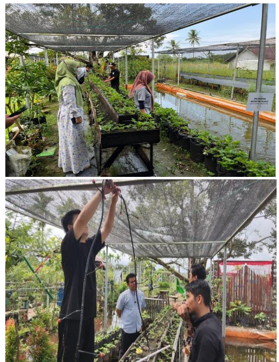
Gambar 3. Instalasi dan Pemasangan Alat Penyiraman Otomatis
