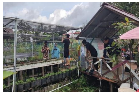
Gambar 5. Kondisi Taman Inspirasi Strawberry Setelah Pemasangan Sistem IoT
